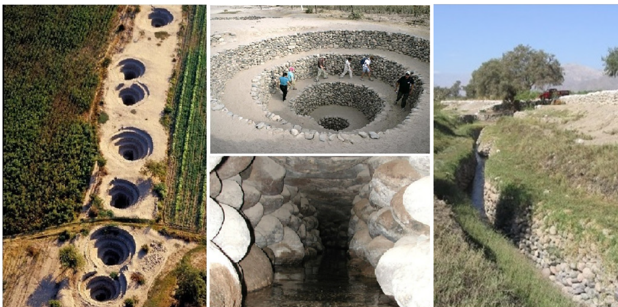
Figura 3. Puquio tipo zanja llenada ( www.elsalvador.com ). Chimenea u “ojo” de sección helicoidal con canto rodado ( www.urbonu.com ) y detalle de la galería subterránea y vista de zanja abierta ( www.hidraulicainca.com ).
