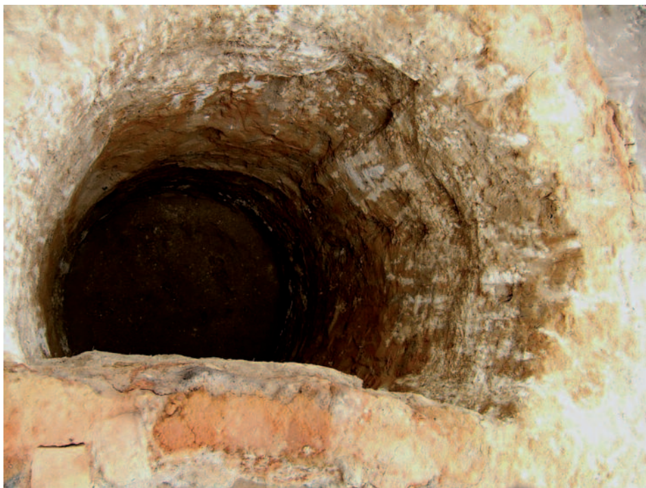
Ilustración 2. Fotografía del pozo B-IV en proceso de excavación.
