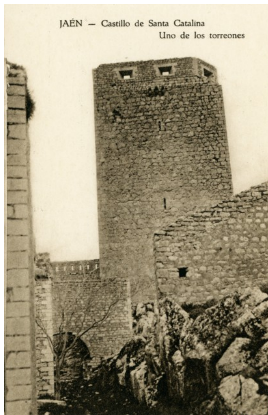
Postal de la torre del homenaje, desde el "Alcázar Viejo", en la que podemos apreciar las troneras para la artillería, en la parte superior de la torre.
