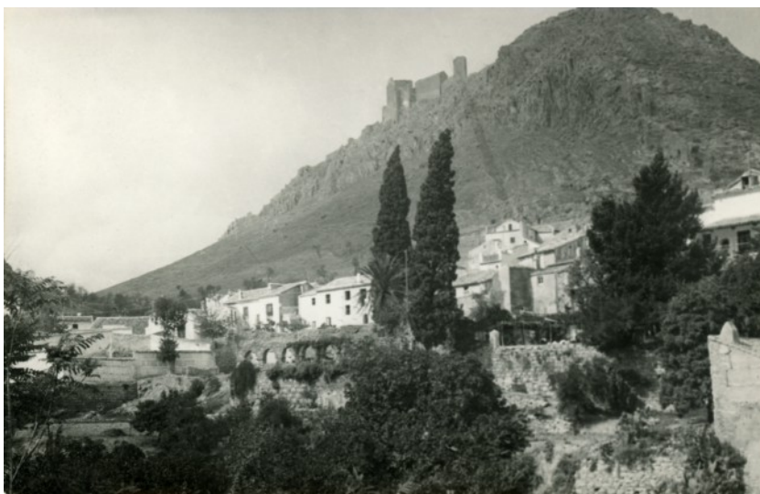
Fotografía del lado sur del cerro de Santa Catalina, desde la Senda de los Huertos, con el acueducto en primer plano.
