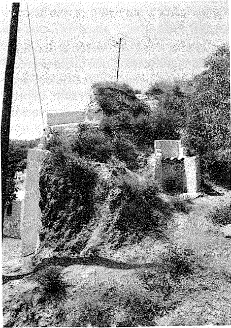
Foto núm. 1.- Cuando las cuevas se emplazan en pequeños montículos, las habitaciones se distribuyen a su alrededor, siendo posible contar con ventanas
