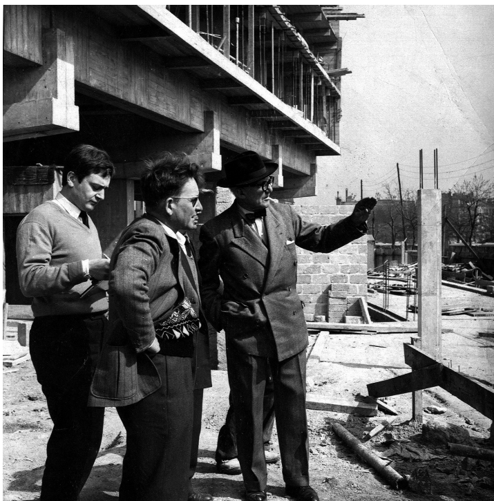
Figura 5. José Oubrerie, Fernand Gardien y Le Corbusier en visita de obra a la Casa de Brasil. Fotografía cortesía de José Oubrerie.
