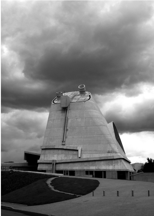
Figura 16. Iglesia de Saint-Pierre de Firminy. Alzado sur. Fotografía del autor.
