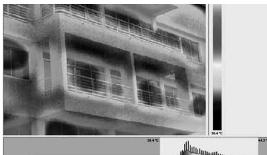
Figura 3. Fachada sur expuesta y sin tratamiento de muros a las 10:00 a. m.
