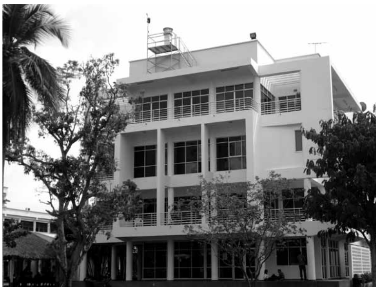
Figura 1. Edificio administrativo Universidad Pontificia Bolivariana, seccional Montería
