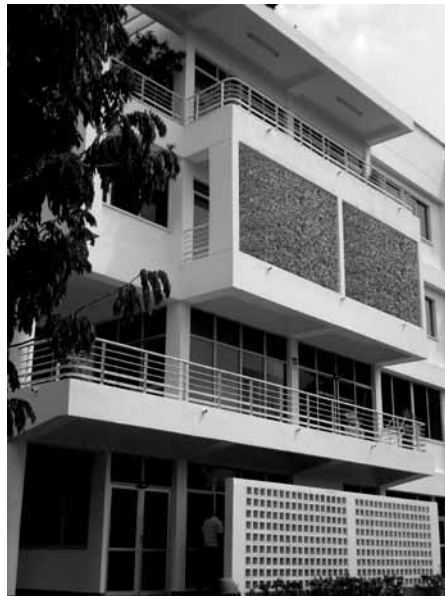
Figura 6. Fachadas verdes instaladas
