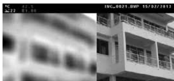
Figura 2. Fachada sur expuesta y sin tratamiento de muros verdes
