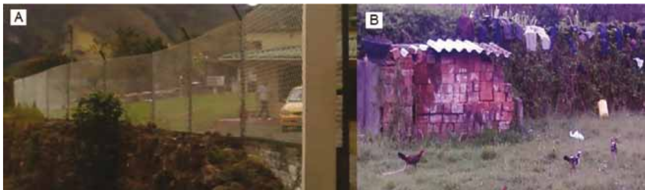
Figura 5. Cercas perimetrales: a) cercas perimetrales en malla; b) cercas vivas
