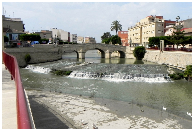
Figura 6. Imagen del puente de Carlos III y del 7° azud, en Rojas.
