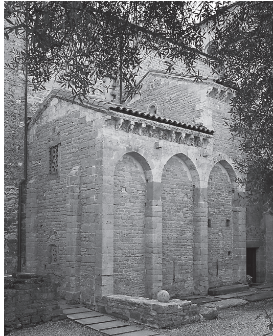
FIGURA 2. Aspecto exterior tras la intervención. Roberto Tolín
