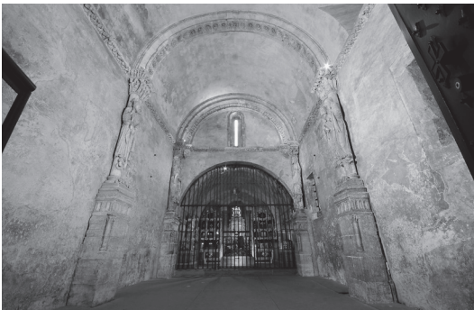
FIGURA 3. Aspecto interior antes de la intervención. Pablo Klett.
