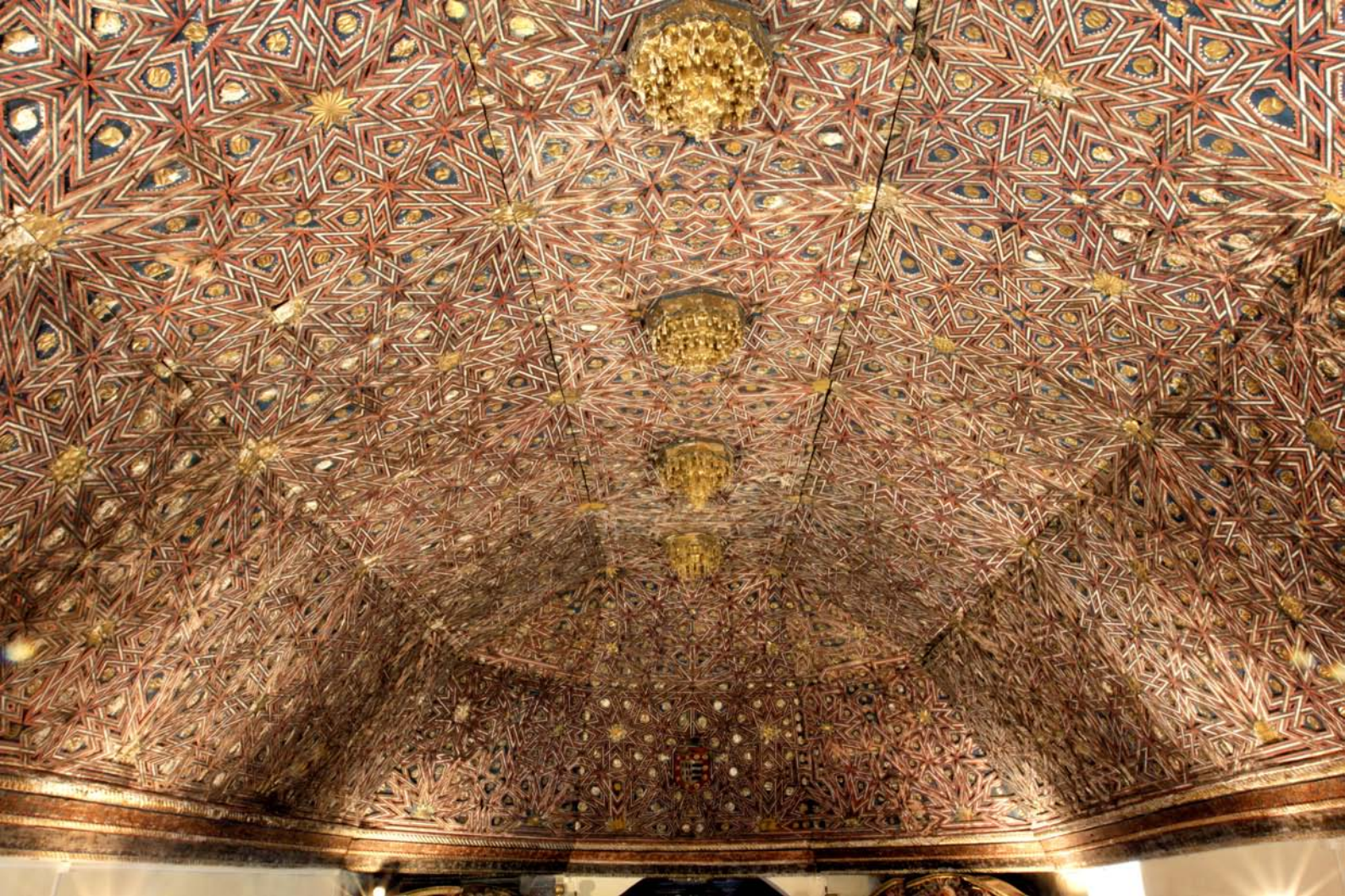
Armadura de la nave. Iglesia de Santa Colomba de la Vega (León). Foto: Fotografía y Vídeo Carrera para la exposición Construyendo firmamentos . Consejería de Cultura y Turismo. Junta de Castilla y León (2013)
