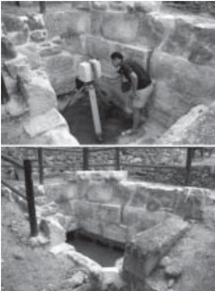
La Fuente de la Salud al término de los trabajos
