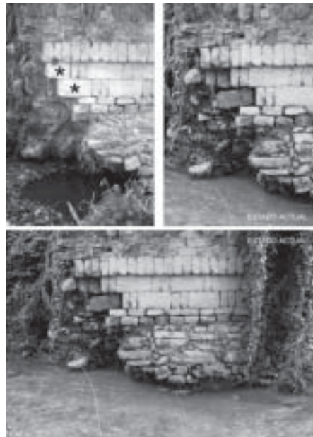
Puente califal del Palancar. Últimos sillares perdidos (asteriscos) durante las crecidas del río
