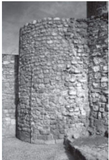
Castillo. Torre 8 al término de los trabajos de consolidación puntual
