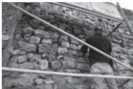
Muralla medieval del Recreo de Castilla. Trabajos de consolidación puntual
