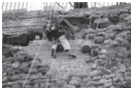
Muralla del Adarve. Trabajos de consolidación en ejecución
