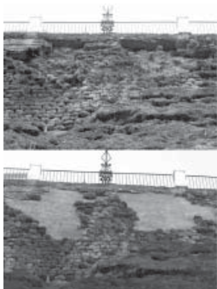
Muralla del Adarve. Estado anterior y posterior a la intervención de urgencia
