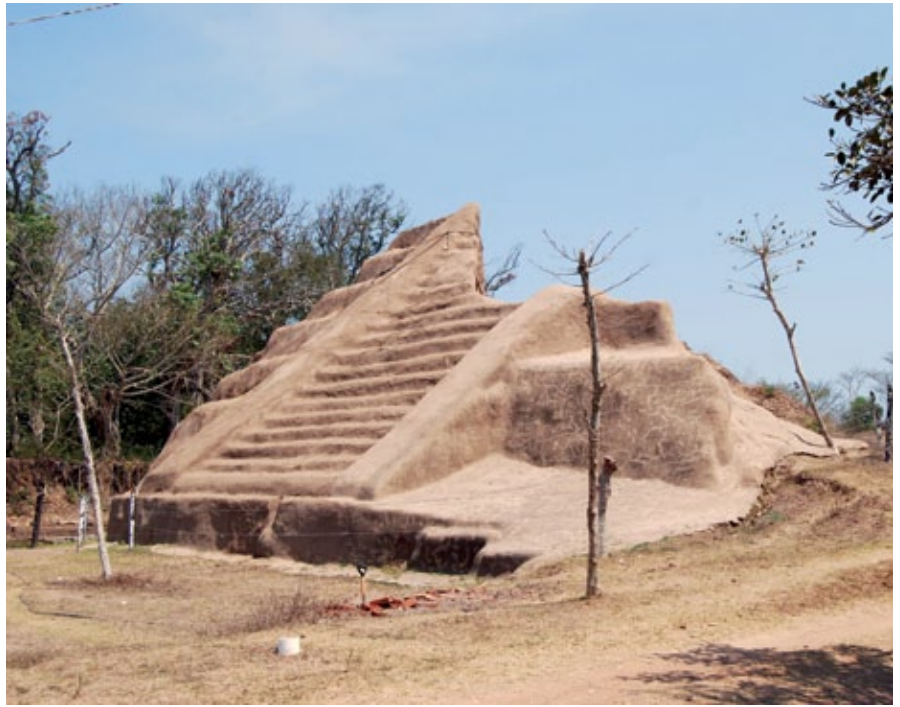
FIGURA 8. Fachada de la pirámide consolidada y protegida (Fotografía: Luis Guerrero, 2009).
