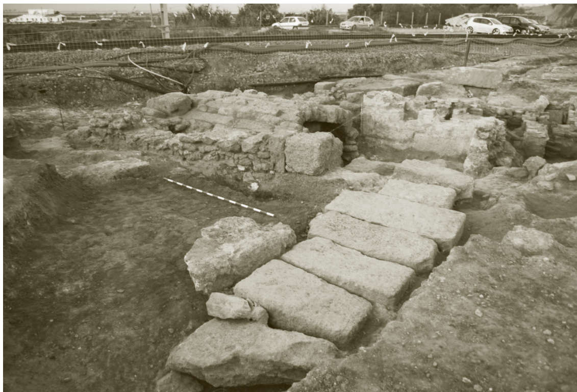
Fotografía 1. Canalización monumental que rodea la cisterna
