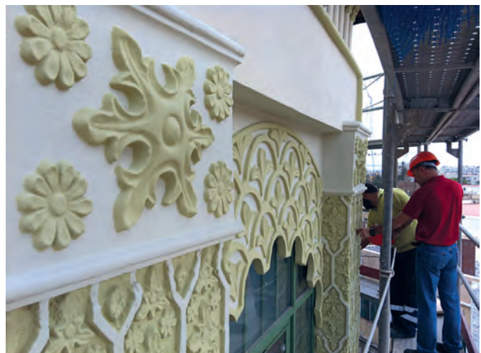
(Figura 9) Trabajos de tratamiento de color.
