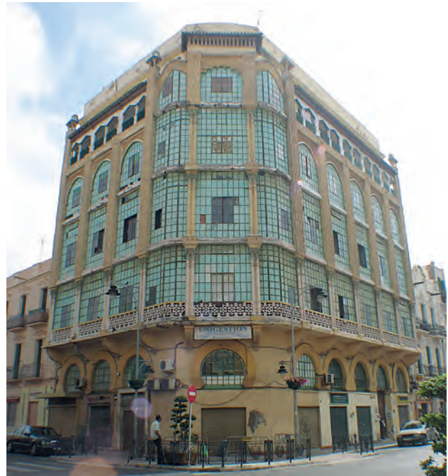
(Figura 2) Vista de la Casa de los Cristales a partir de la reforma de 1980.
