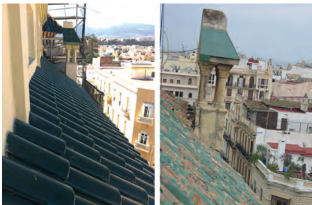
(Figura 5) Detalle de las tejas, antes y después de la intervención.
