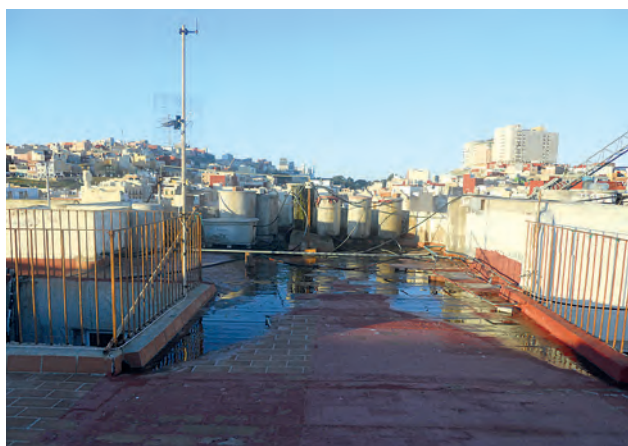
(Figura 4) Estado de la azotea del edificio.
