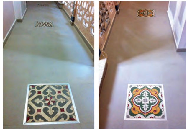
(Figura 8) Solería con la combinación entre gres porcelánico y baldosa hidráulica recuperada.
