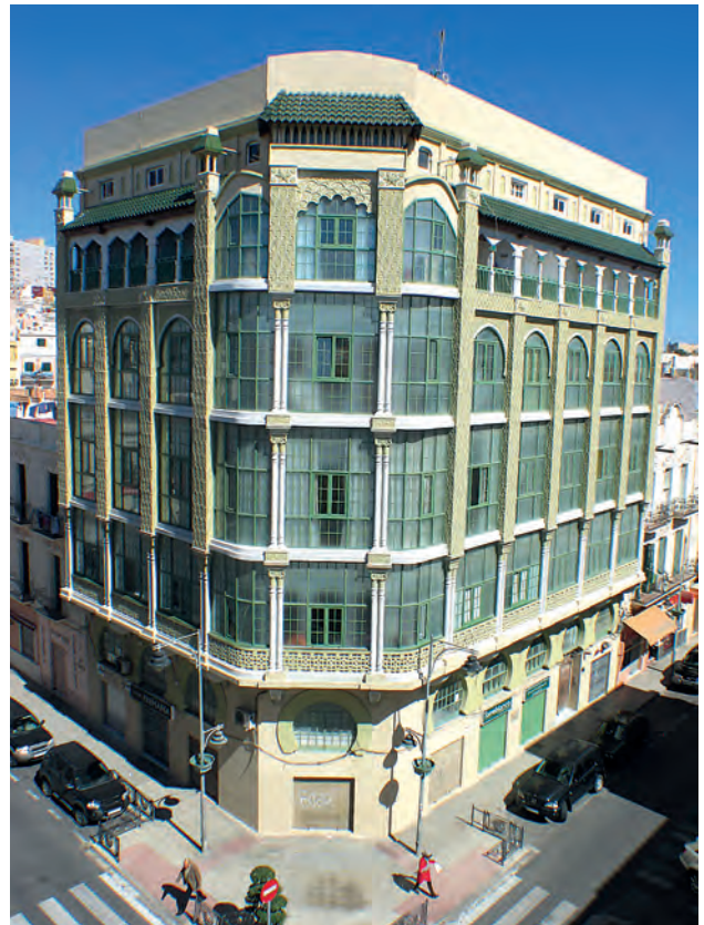
(Figura 11) Vista del edificio después de la intervención.
