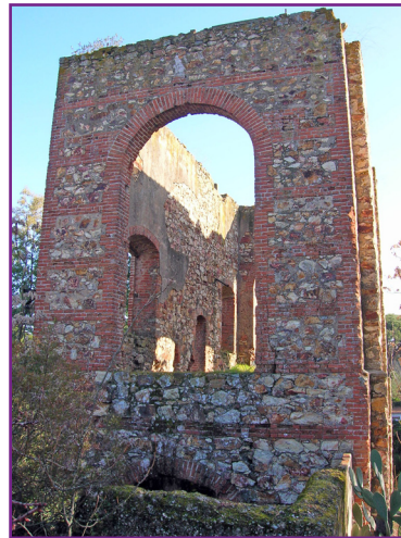
Fig. 3: La tecnología que los ingleses llevaron a Cerro Muriano abrió la puerta a la explotación industrial de sus filones. Casa de la máquina de bombeo principal del filón central o Cerro Muriano, en el pozo maestro San Rafael.
