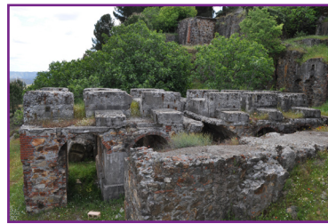
Fig. 5: Estructuras del núcleo principal del taller de concentración magnética Murex, uno de los elementos más singulares del lavadero de Cerro Muriano.
