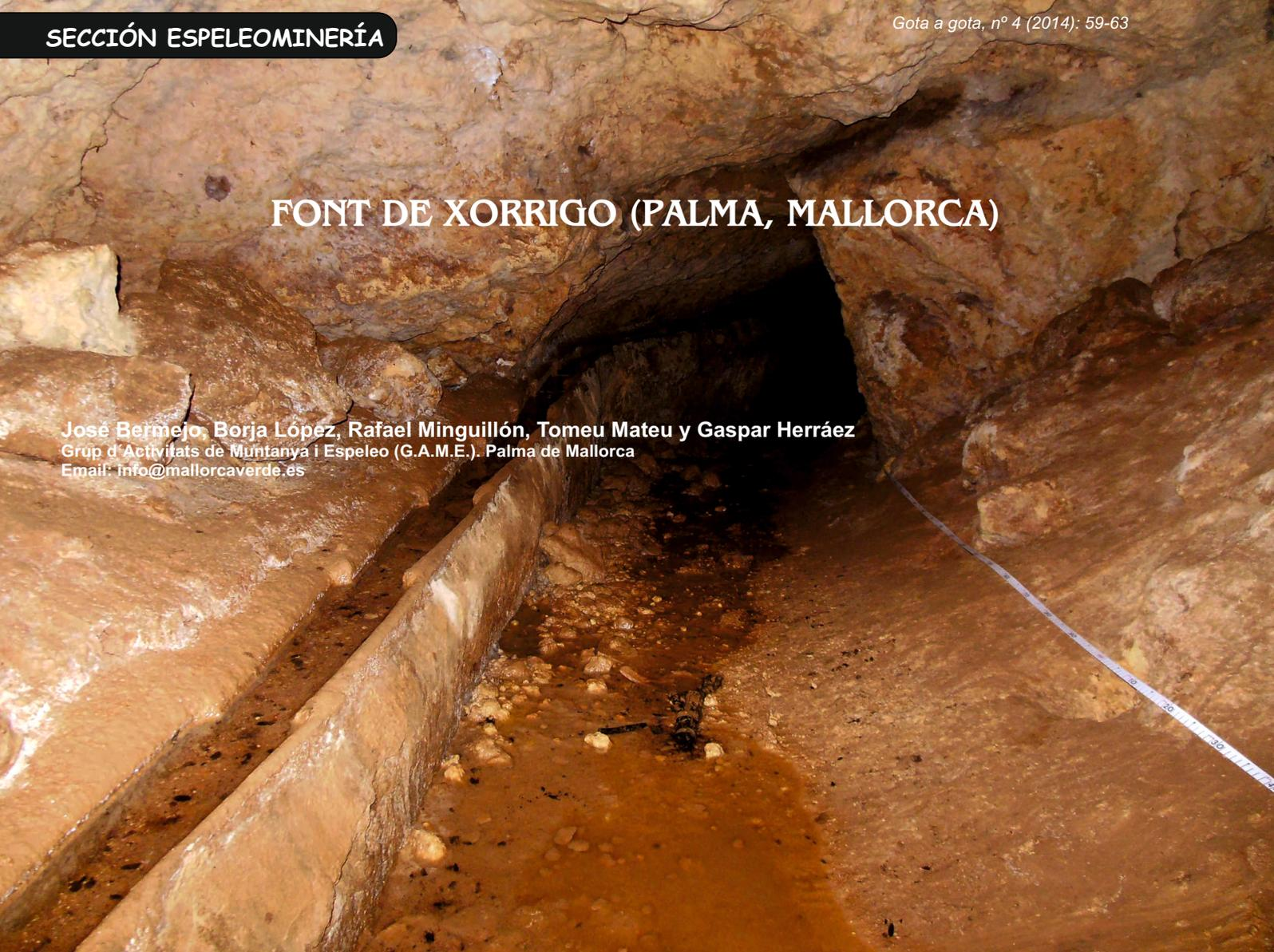
**RESUMEN:** Presentamos la topografía, así como la descripción de una interesante mina de agua, excavada en roca arenisca, de época árabe. Se caracteriza por una trinchera de más de 50 m abierta al exterior seguida de una galería de otros 50 m que alcanza la fuente. Al inicio de la galería se accede a una sala en un nivel superior. La galería mencionada presenta una canaleta que transporta el agua de la fuente al exterior.
