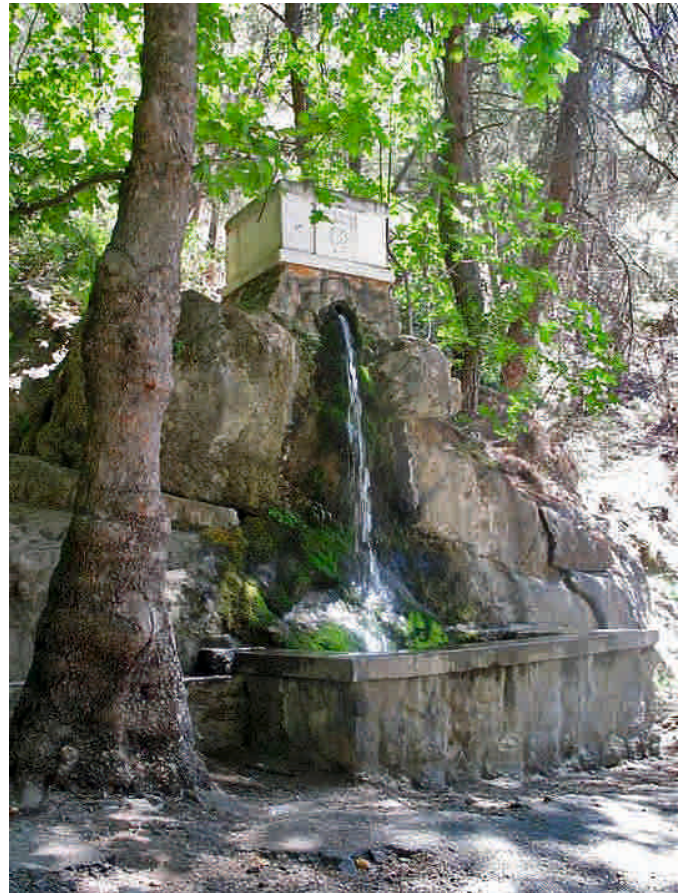
En cualquier cruce de caminos o cerca de cualquier carretera, como es el caso de la fuente de Los Mansegosos, podemos encontrar numerosos manantiales o rezumes, que fueron captados por el hombre y arreglados en forma de fuente para su aprovechamiento (foto J.D. Cano Cavanillas, agosto de 2005)
