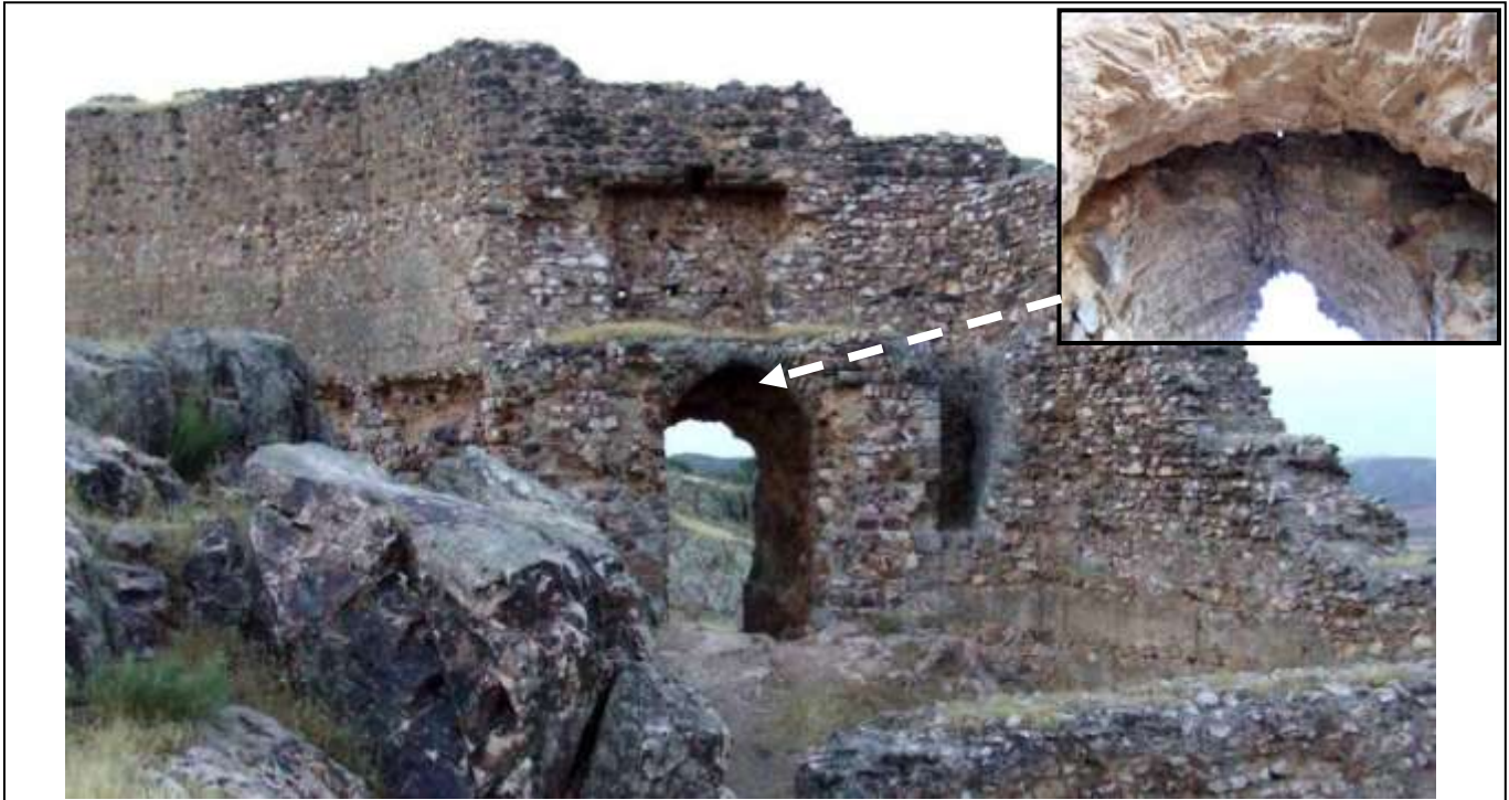
1. Vista interior al acceso de la fortaleza con detalle al intradós de la bóveda del vano de acceso, vista desde el exterior.
