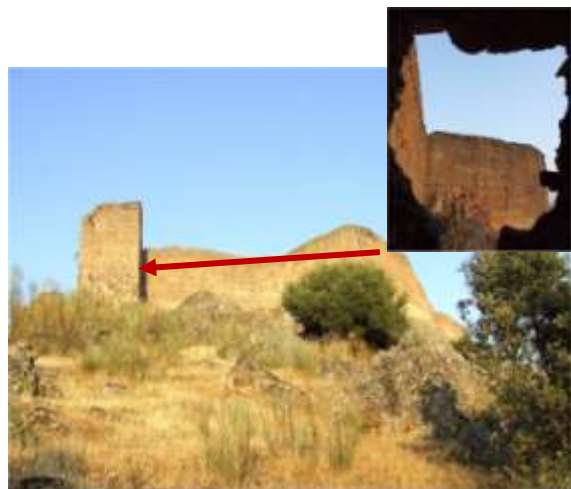
3. Vista flanco Sur y detalle desde el interior de la "ventana" de la Torre del Homenaje
