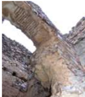
3. Arco y jamba oeste de acceso a la torre.
