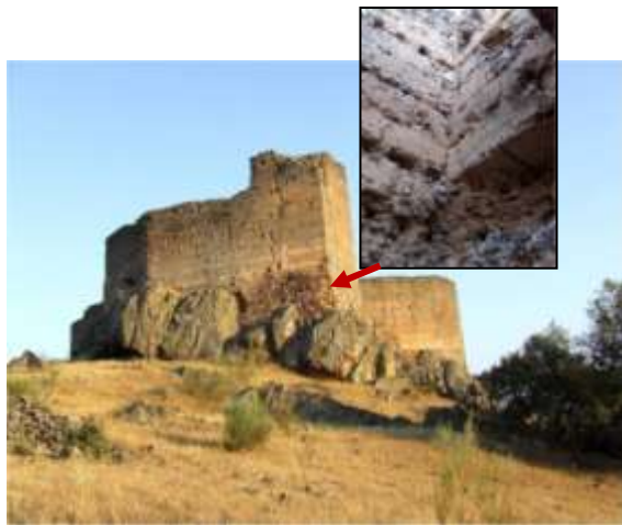
2. Vista flanco Oeste y detalle del ángulo Noroeste del interior de la torre
