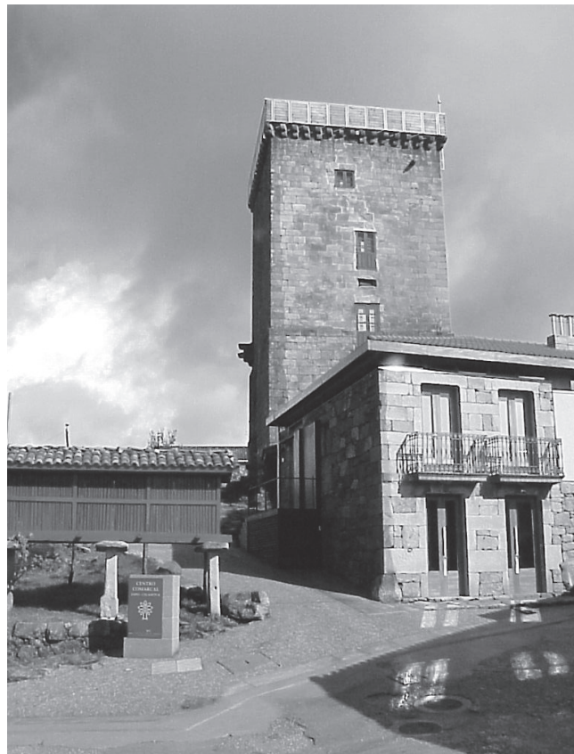
Fig 3. Foto del autor. "Centro Comarcal de Terra de Celanova". Vilanova dos Infantes. Celanova. Ourense. 1999.
