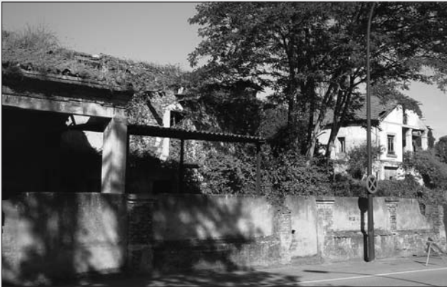
ESTADO ACTUAL DE LOS “CHALETS” DE D. JUSTO, EN POSADA DE LLANERA. FOTO CHEMA MARTÍNEZ
