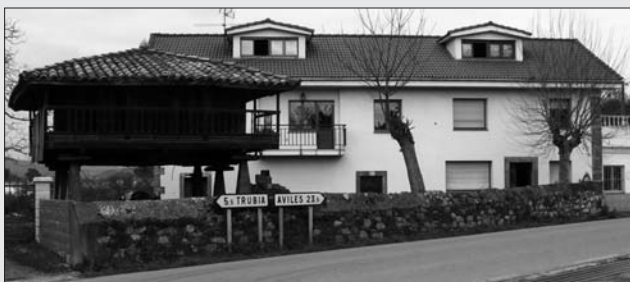
CASA EL JUEZ EN ESCAMPLERO, DONDE ESTUVO EL HOSPITAL DE SAN MIGUEL. FOTO J. I. PRIETO
