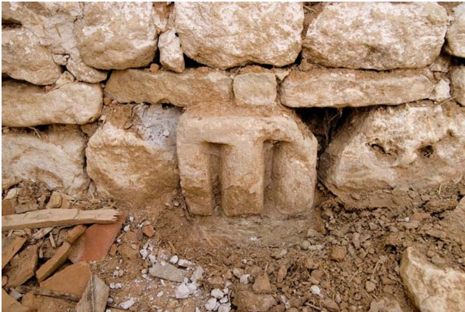
Desechos de taller escultórico utilizados en la cimentación de una casa de Villaescusa de Ecla.
