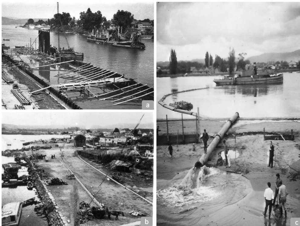
Figura 3. Reconstrucción de la Avenida Costanera tras el terremoto de 1960.
