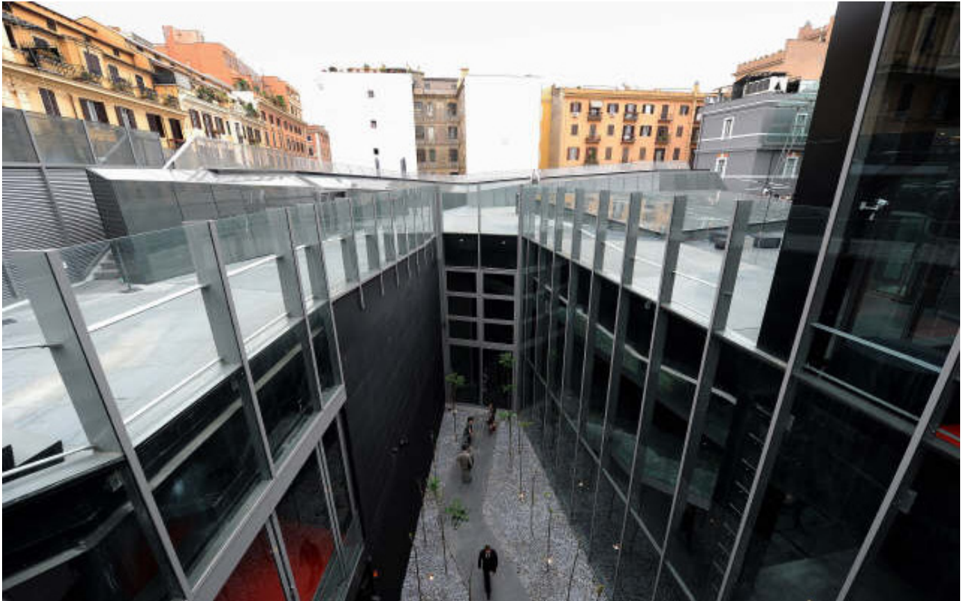
Vista desde las cubiertas en la segunda intervención.
