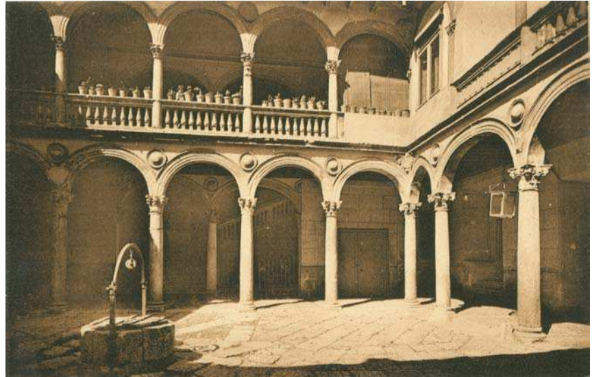
Patio del Palacio de Fabio Nelli cuando aún servía como vivienda.
