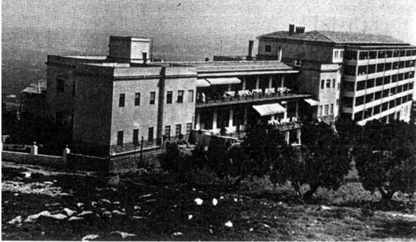
Sanatorio «El Neveral». A la izquierda el primitivo pabellón
