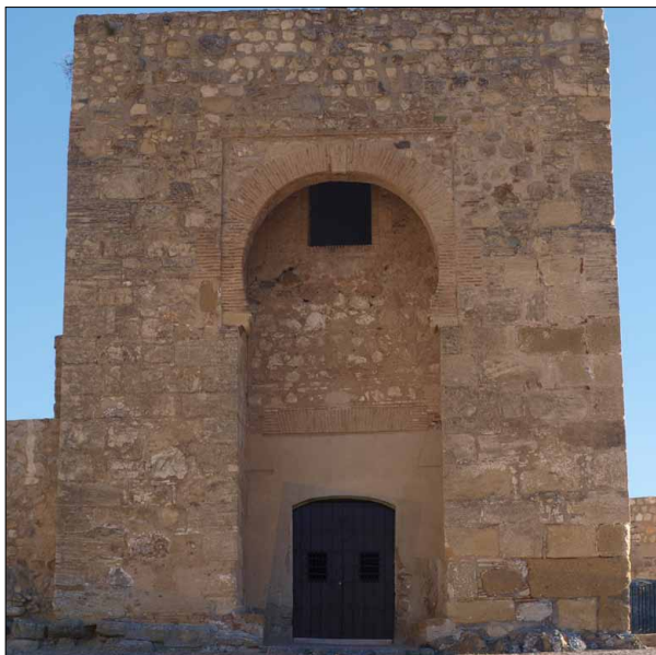
Lámina 2. Puerta de Malaga en la cara S-O.
