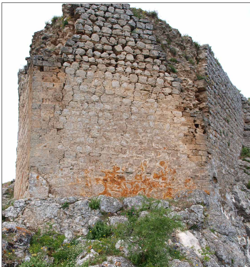
Lámina 9. Torre 7 en la cara S, del primer cinturón de las murallas
