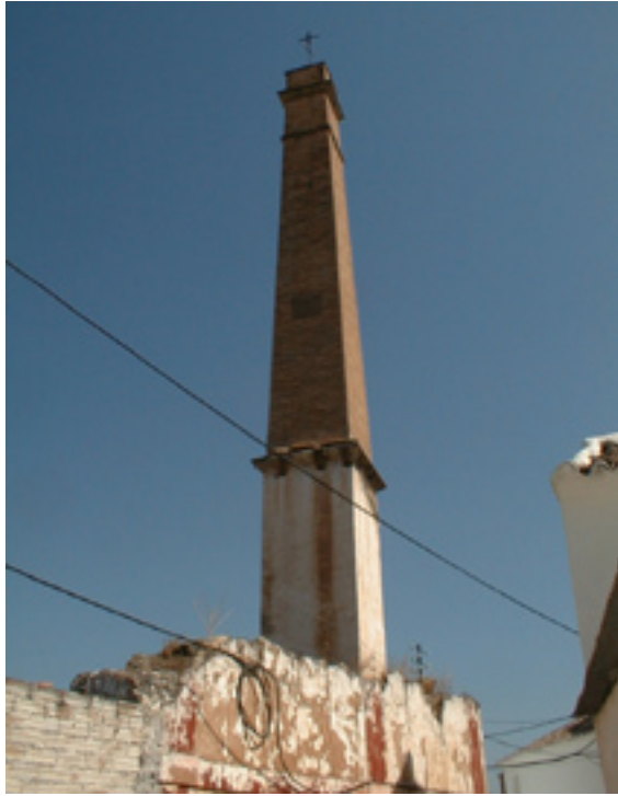
Chimenea en calle la Venta
