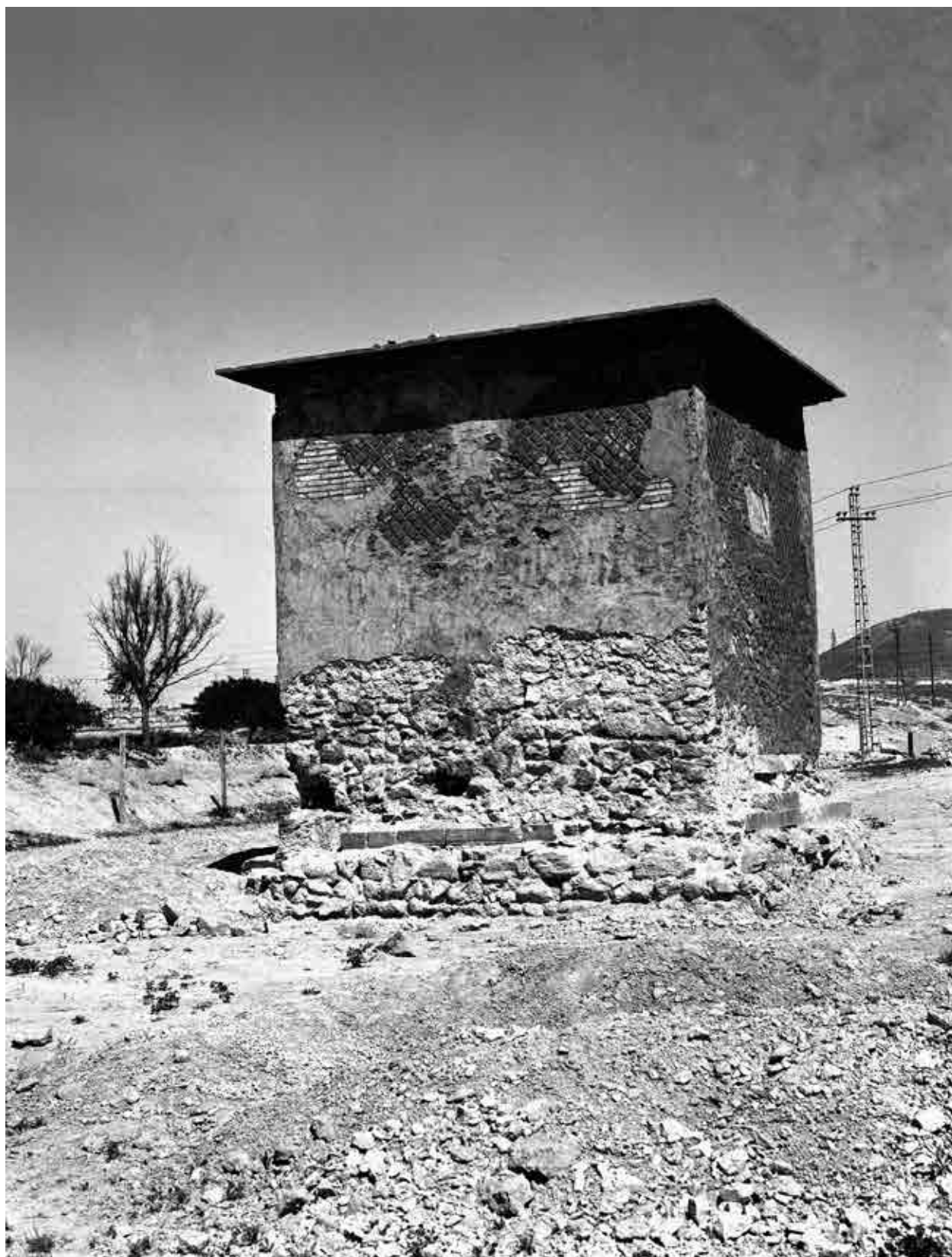
Fig. 1.- Estado de la Torre Ciega previo a la restauración de P. San Martín Moro, tras eliminar la verja levantada en la intervención de A. Beltrán (D-DAI-MAD.WIT-R-123-67-04).
