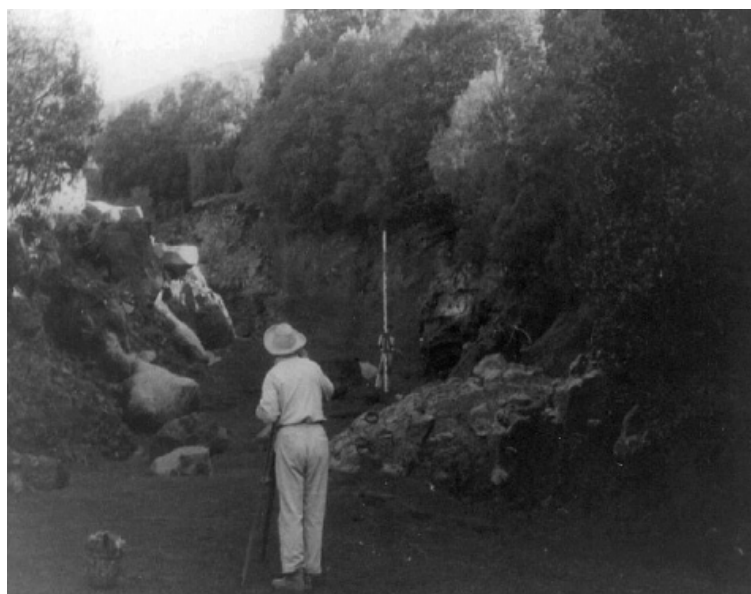
Ilustración 1. Trabajos de replanteo de hidrotecnia en el barranco de Amargavinos Isla de La Palma. Fuente: ORTUÑO MEDINA, 1957
