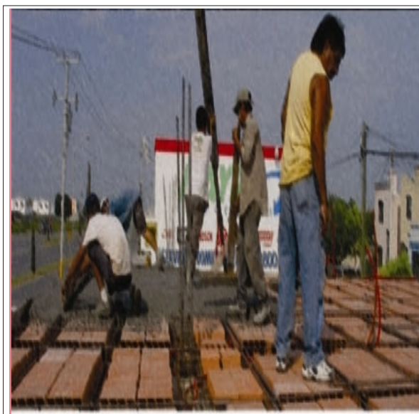
Imagen 1. Trabajadores en la construcción.
