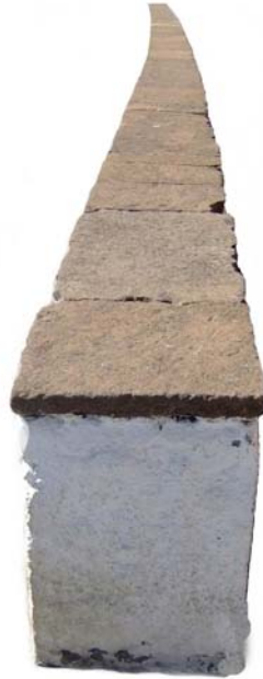
Muro actual situado en los Balcones de la Avenida
