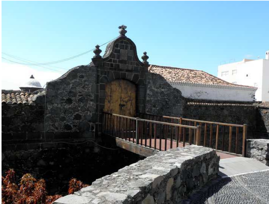
Vista de la entrada principal del Castillo de Santa Catalina. 2012
