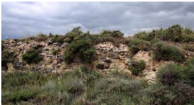
Lámina 71. Matorrales en los intersticios del Lienzo A. Estado previo a su desbroce.
