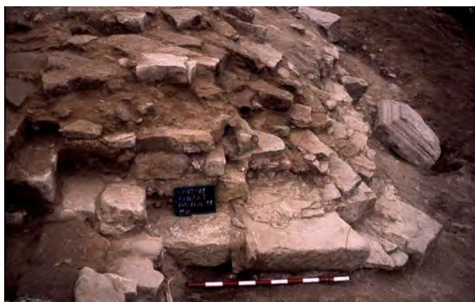
Lámina 58. Pilastra reutilizada como cimentación del Cubo 11. Cedida por: Javier Ceniceros.
