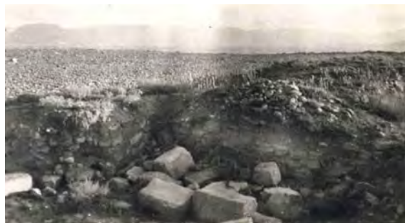
Lámina 9. Acopio sillares en el lado este de la ciudadela, zona de la entrada original. 1956. Ayuntamiento de Logroño.
