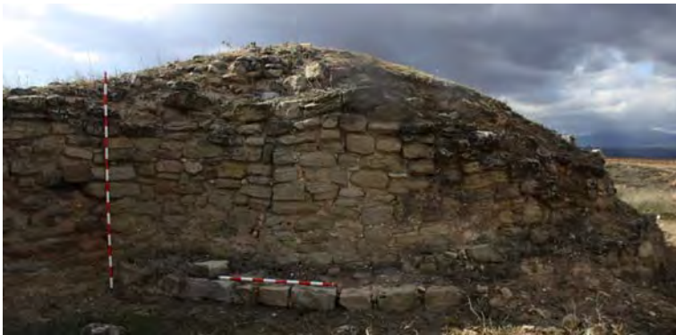
Lámina 56. Cubo 5 trabado con la fábrica del Lienzo D.
