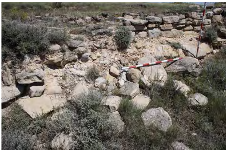
Lámina 64. Derrumbes en el Lienzo I.
