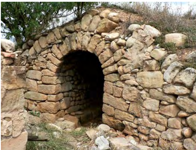
Lámina 4. Edificio refugio ubicado en las laderas occidentales del Monte Cantabria.
