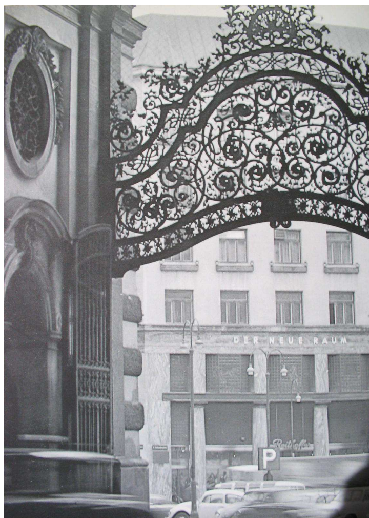
Figura 1. Edificio en la Michaelerplatz de Viena (1911). Arq.: Adolf Loos.
