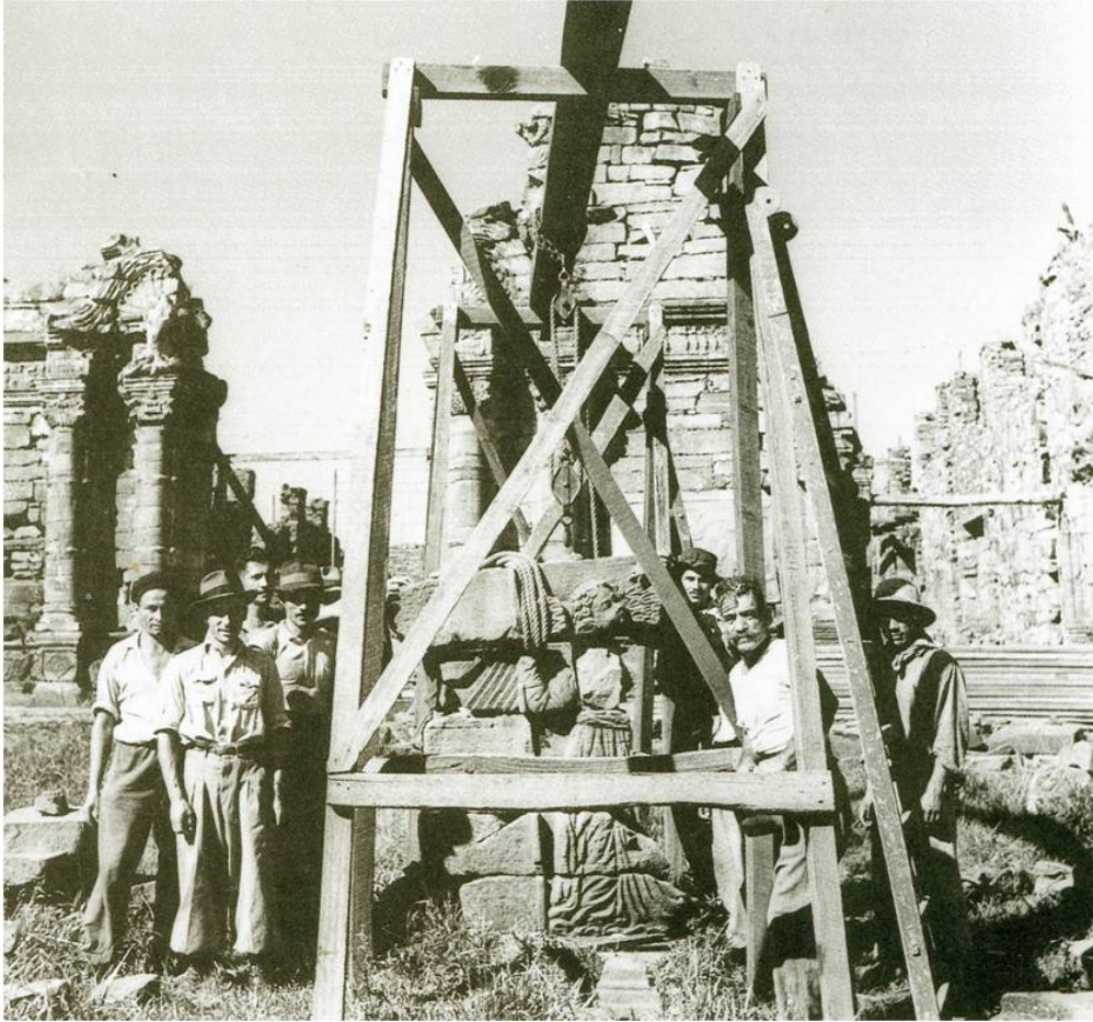
El arquitecto Carlos L. Onetto en la tarea de reposición del ángel de la fachada de San Ignacio Mini.
