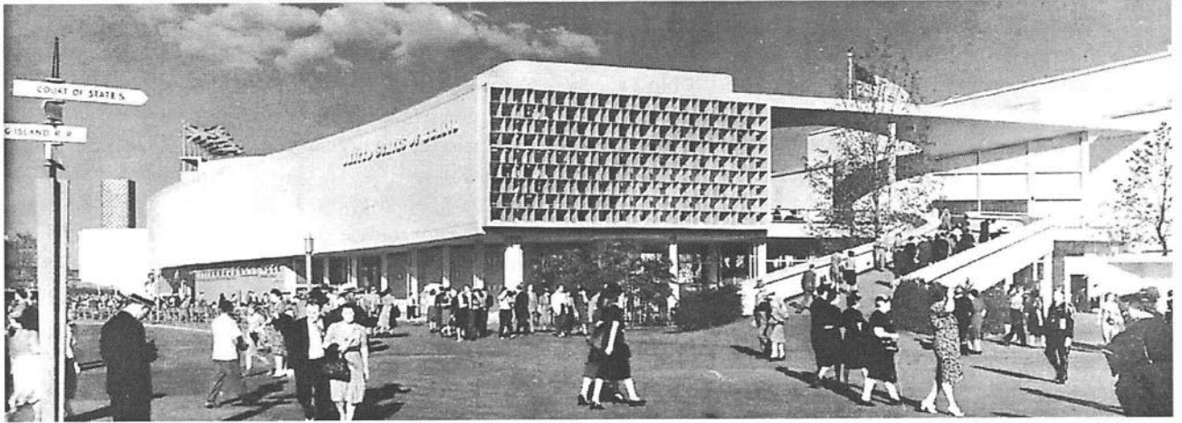
Vista principal desde la avenida.
