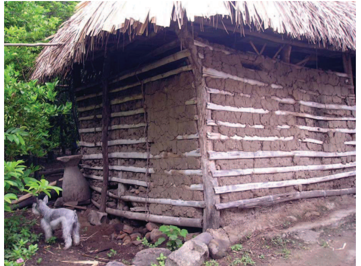
Construcción según la técnica del bajareque, Colombia.
