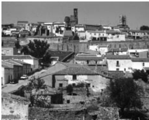
Figura 1. Vista de Almadén desde el Sur. Mina del Castillo
