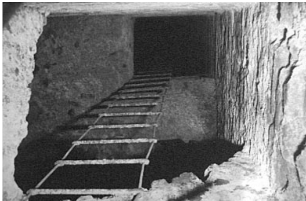
Figura 8. Pozo auxiliar San Andrés
