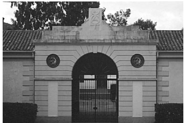
Figura 10. Almacén de mercurio, construido en 1941. Minas de Almadén
