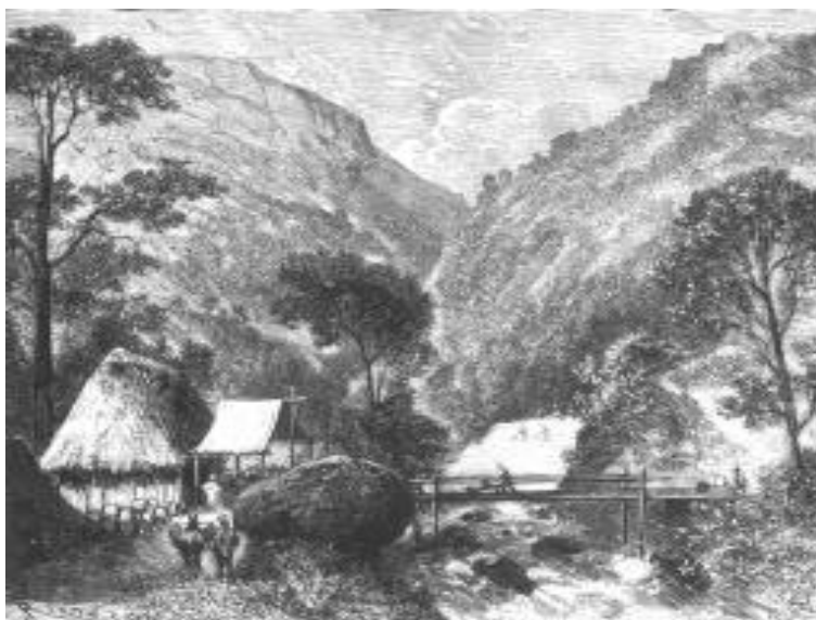
Puente en la salina de Upin
