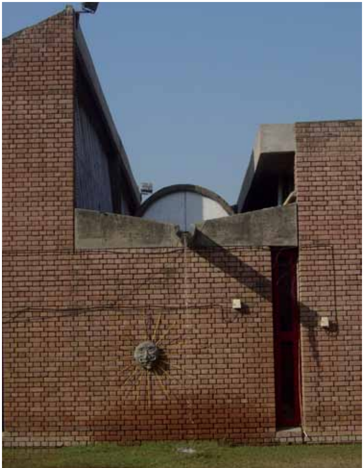
Figura 12. Le Corbusier. Escuela de Arquitectura de Chandigarh (1961): fotografía desde el interior del patio. La bóveda y la cubierta inclinada permiten la entrada de luz natural al interior. En el centro de la imagen una gárgola que desagua la cubierta. ©María Cecilia O'Byrne.
