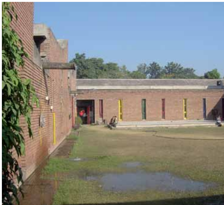
Figura 34. Le Corbusier. Escuela de Arquitectura de Chandigarh (1961): en el patio las gárgolas derraman el agua sobre el césped y dejan su huella tanto en el terreno como en la pared del edificio. ©María Cecilia O'Byrne, 2008.
