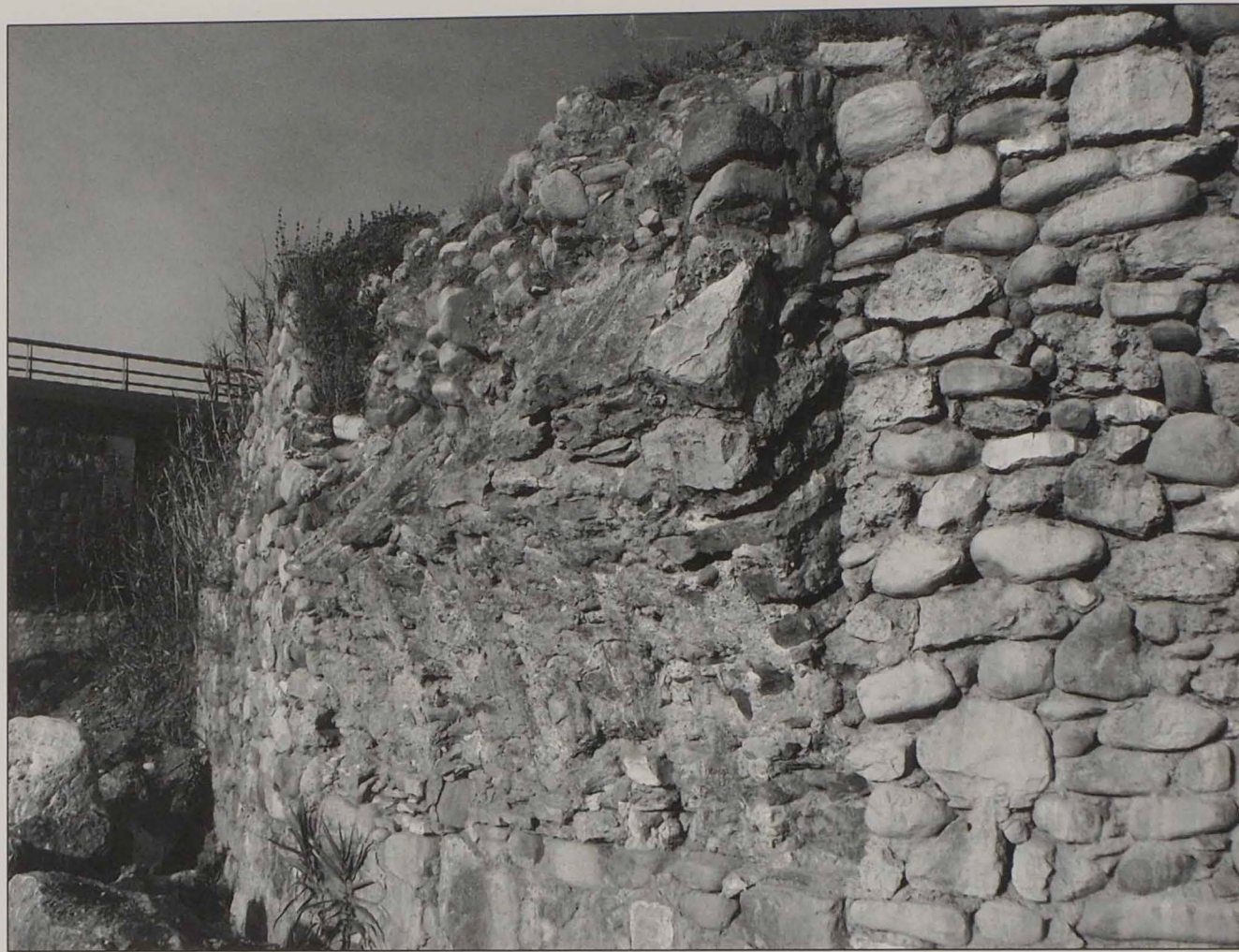
Arranque del puente en la orilla izquierda.
