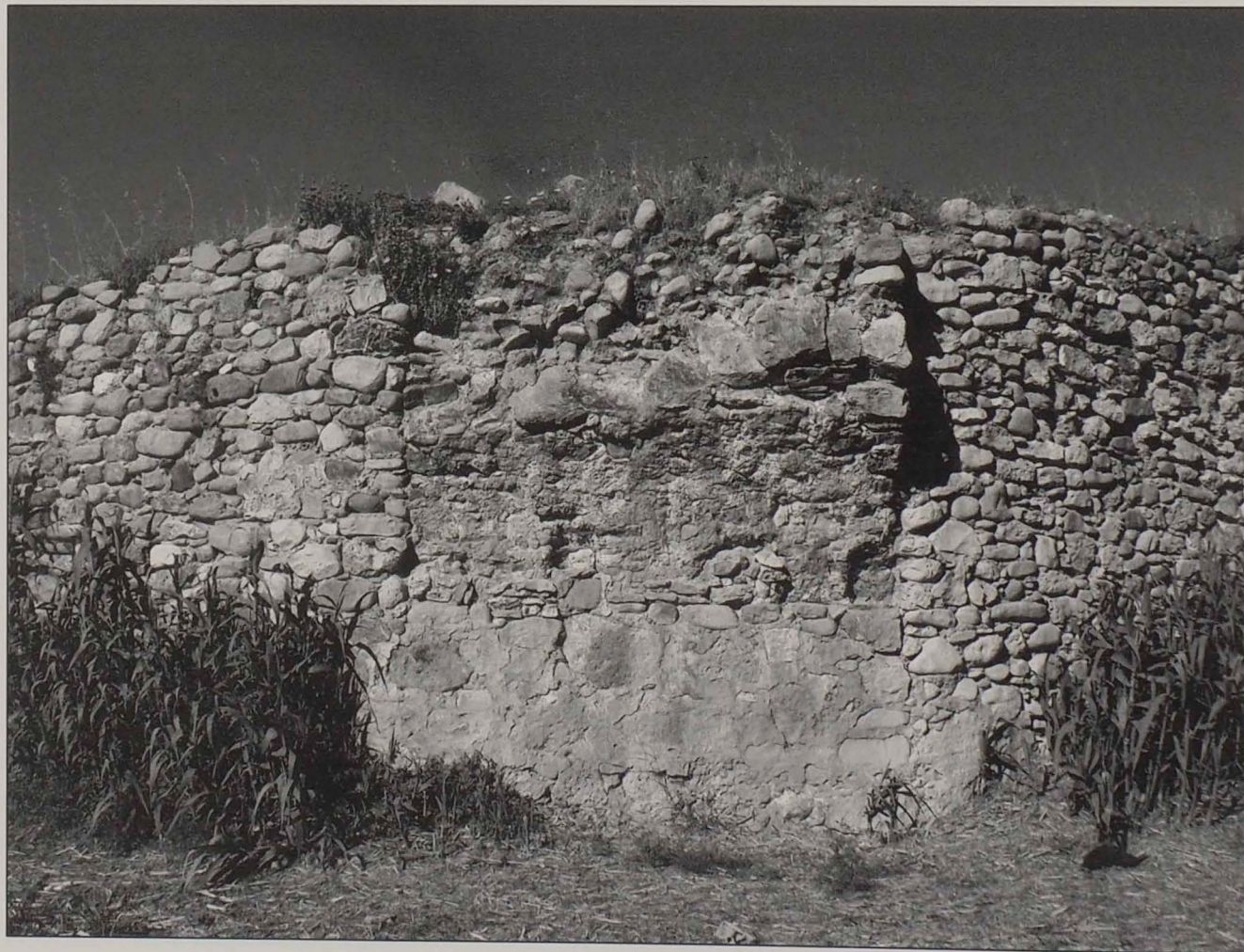
Vista frontal del arranque izquierdo, distinguiéndose sus diferentes niveles constructivos.
