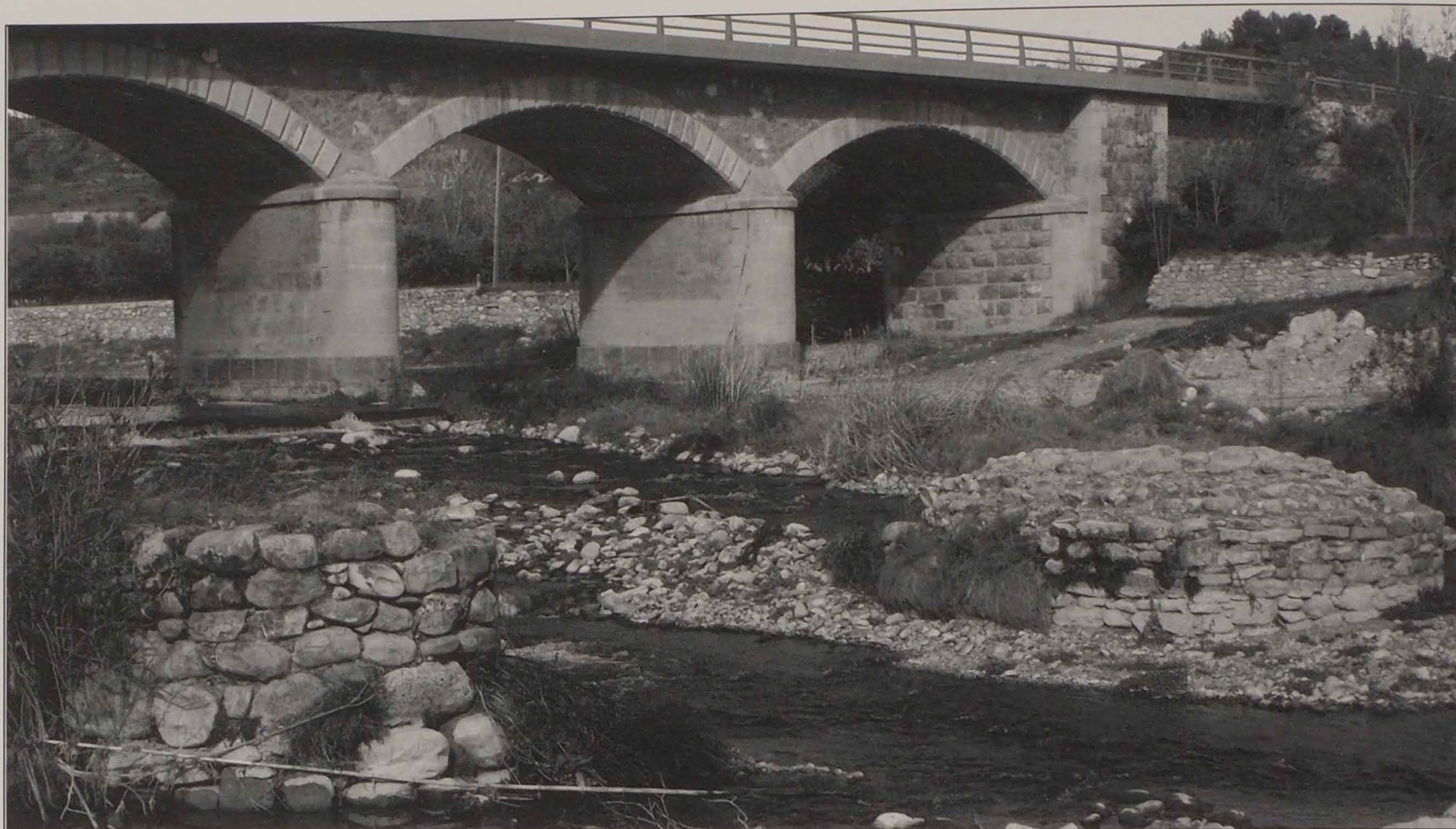
Machones del antiguo puente y, tras ellos, el puente actual.
