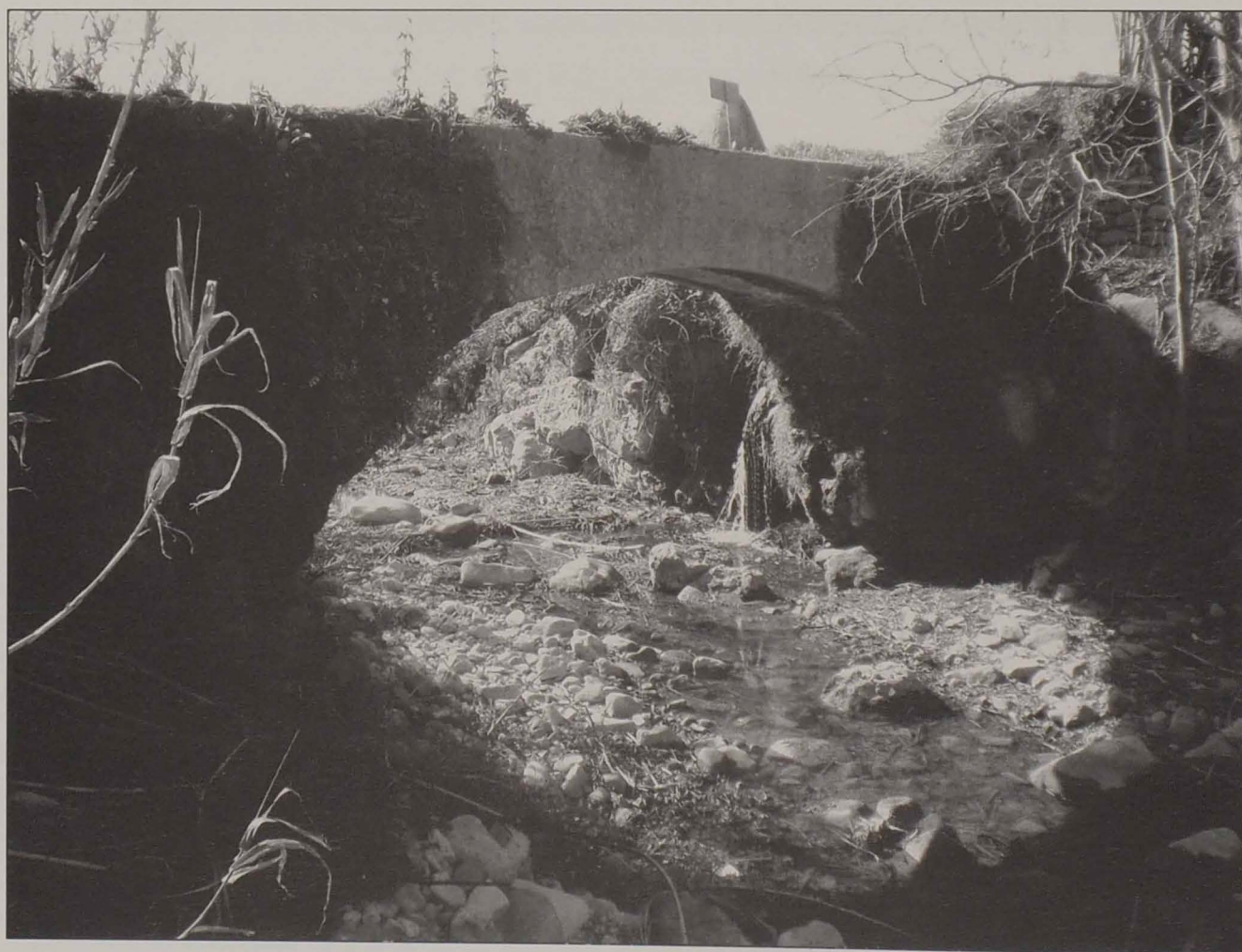
Acueducto de la acequia de Vallel.
