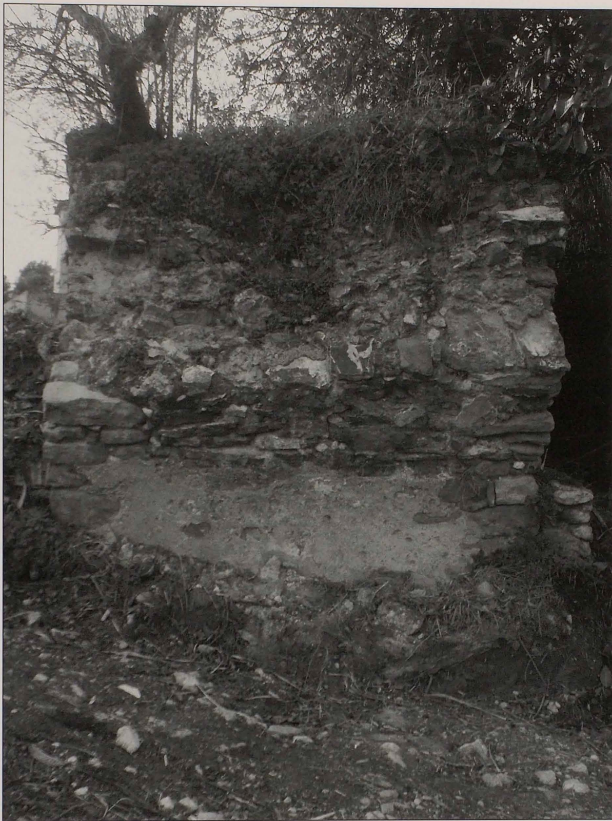
Arranque del puente en la orilla derecha.
