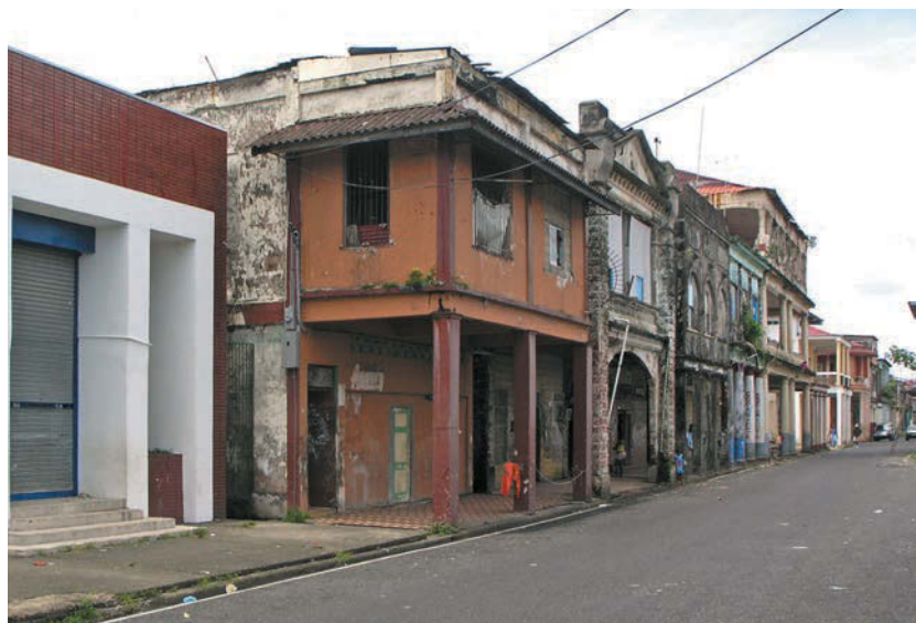
Figura 20. La avenida del Frente hoy, entre las calles 7 y 8. Este tramo de la avenida es el mismo que se aprecia en la Figura 19. (Foto del autor)
