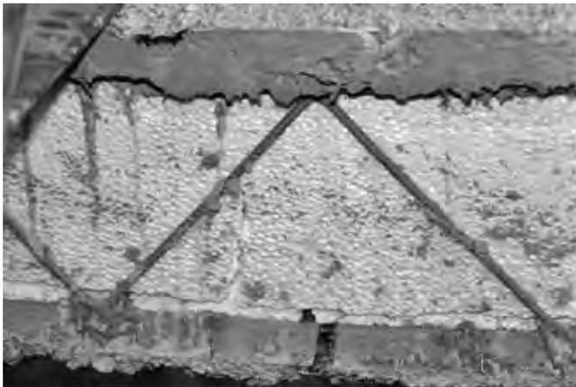
Figura 8. Fractura del acero longitudinal y separación de la lámina calibre 20 correspondiente al nervio
