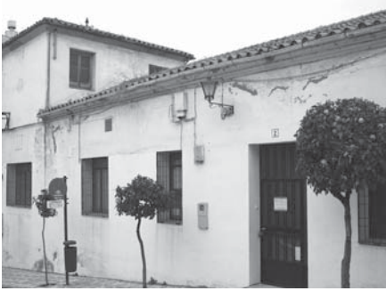
Edificio anexo a Carnicerías
