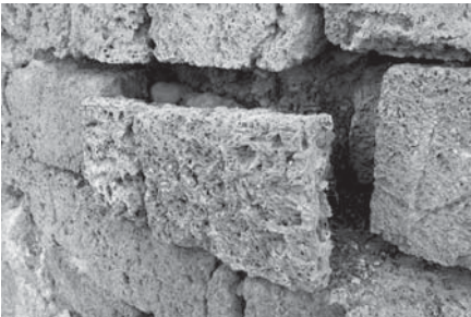
Castillo de Priego. Torre 2. Detalle de sillares antes de su recolocación
