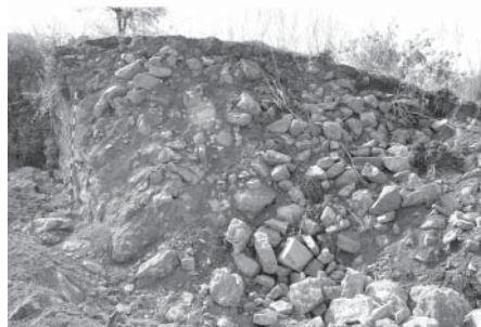
Las Cabezuelas del Tarajal. Muralla del oppidum dañada
