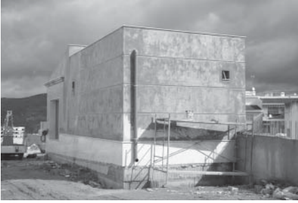
Horno de cal hispanorromano. Edificio en construcción para su puesta en valor
