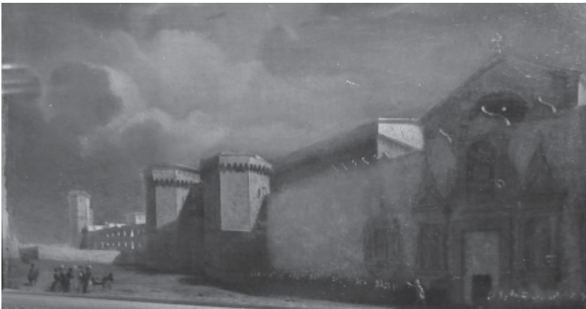
Façana de l'església, Porta reial i tram de muralla. Marià Fortuny. (Fig. 4)
