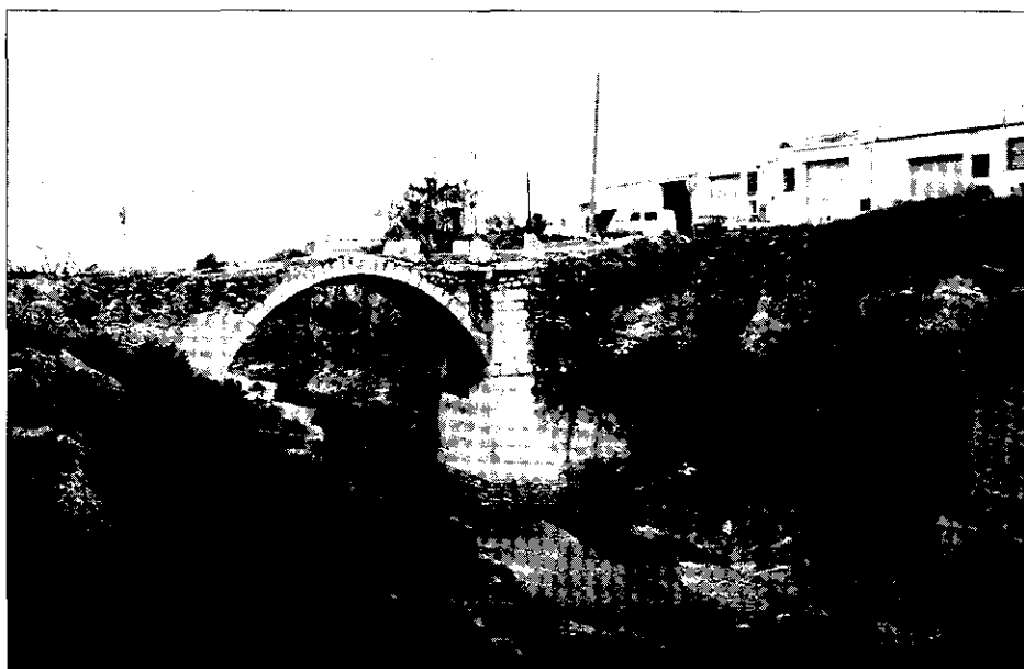
Fotografía 7. Puente de arcada única, construido sobre el Cervol durante el siglo XVIII, que atravesaba la antigua carretera a Barcelona, en las inmediaciones de Vinaròs. Fue afectado por una crecida registrada en 1844 y reconstruido posteriormente. En la actualidad está fuera de servicio, ya que la N-340 discurre más próxima a la costa.
