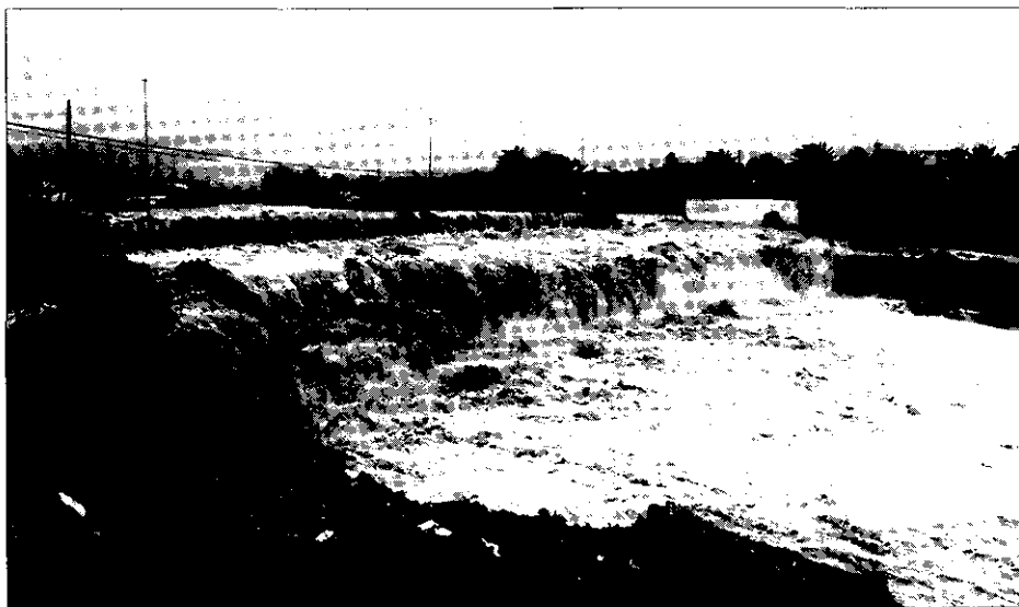
Fotografía 5. Crecida registrada en el Barranc de la Barbiguera el 11 de Octubre de 1994, en el mismo punto de la foto nº 5. El caudal superó el puente de la carretera, formando, aguas abajo, una espectacular cascada en el escalón del lecho (Fotos DIFO'S).
