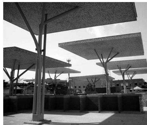
Plaza para Ocupantes del Espacio Público, OEP, Barranquilla, TRANSMETRO S. A. Foto. Carlos A. Molina
