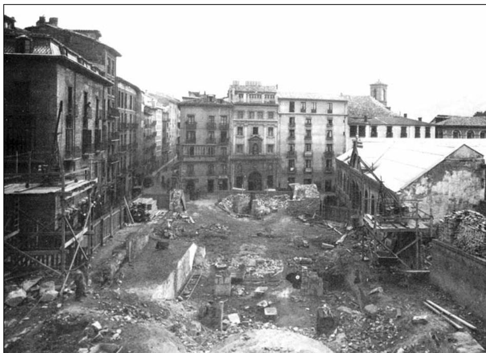
Fig. 28. Solar resultante del derribo de la Casa Consistorial. Año 1952. AMP
