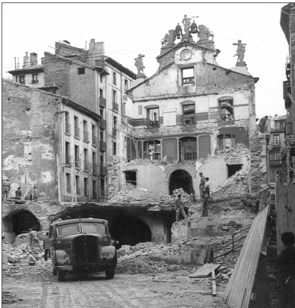
Fig. 27. Parte posterior de la Casa Consistorial con la fachada en pie. Año 1952. AMP (Foto Julio Cía)
