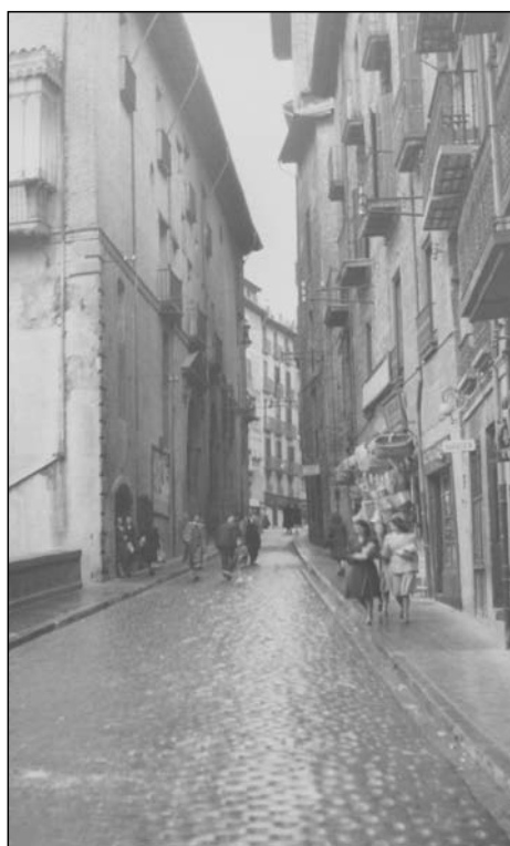
Fig. 3. Trasera de la antigua Casa Consistorial y fachada orientada a la Plaza de Santo Domingo (h. 1950). AMP
