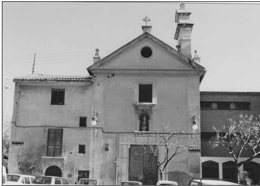
1) Fachada de la Iglesia del convento de Carmelitas descalza de San José y Sta. Teresa de Valencia.
